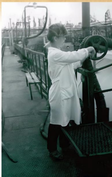
Пломбирование задвижек на маслопроводе, А.М.Мустафаева
